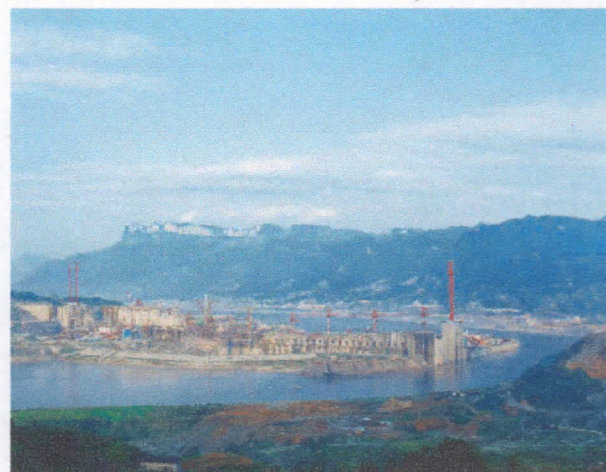
Fig. 5.18. En China se encuentra la mayor central hidroeléctrica del mundo (La Presa de las Tres Gargantas); para su construcción se inundaron 13 ciudades y 140 pueblos y se forzó el desalojo de más de un millón de personas.
